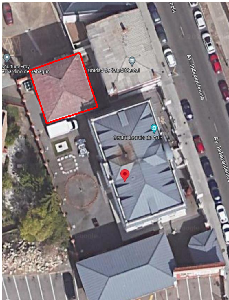
PROYECTO DE SUSTITUCIÓN DE CUBIERTA EDIFICIO DE TALLERES CLA - ILC - LEÓN
