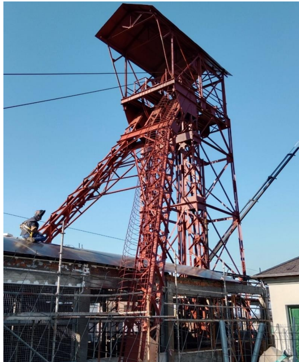
Restauración del castillete del pozo Julia en Fabero
