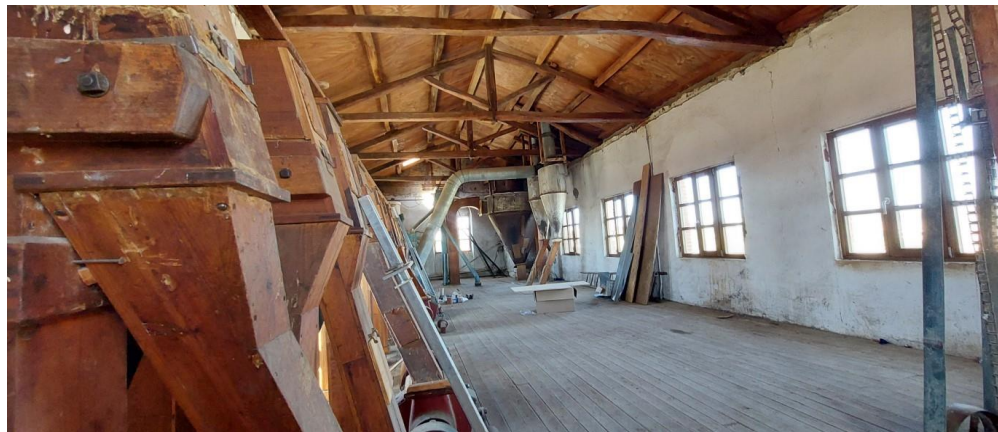
Restauración de la fábrica de harinas "La Rosario" en Astorga
