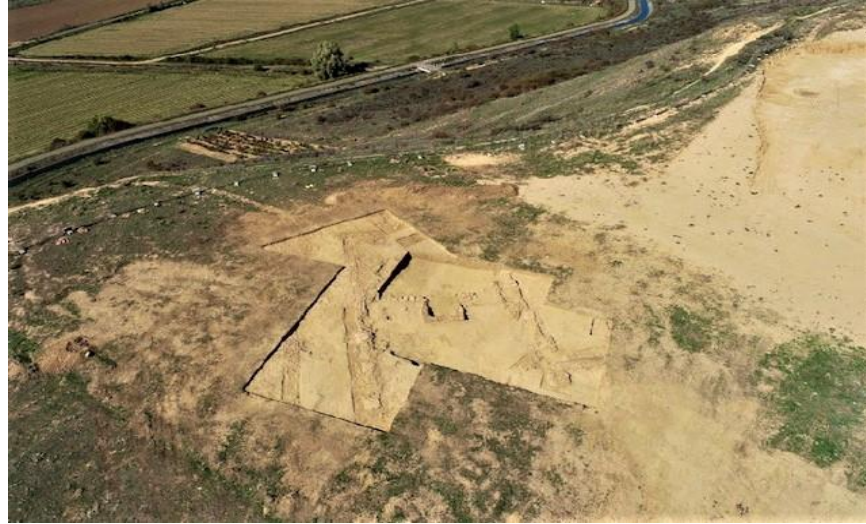
Obra de construcción del Centro Arqueológico de Lancia. Aparición de estructuras arquitectónicas romanas en el subsuelo del edificio n.º 3, razón por la que se ha planteado una nueva ubicación del edificio
