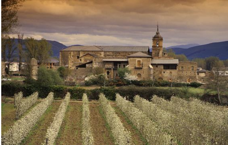
Monasterio de Sta. María de Carracedo antes de la intervención de restauración programada
