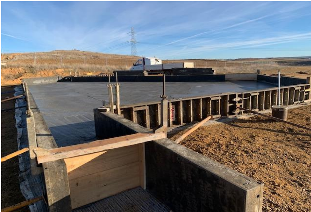
Vista aérea de la zona de implantación del Centro Arqueológico de Lancia y construcción de solera de cimentación del edificio n.º 1
